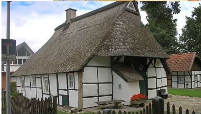
Mehrere Jahrhunderte hat das Krippken aus Mettingen auf dem Buckel: An dem historischen Fachwerkhaus hat Tim Steinemann für seine Weiterbildung zum Restaurator im Zimmererhandwerk alte Eichenbalken fachgerecht ausgetauscht. Das aus dem 16. Jahrhundert stammende Gebäude steht seit 1984 unter Denkmalschutz. Foto: Tim Steinemann
